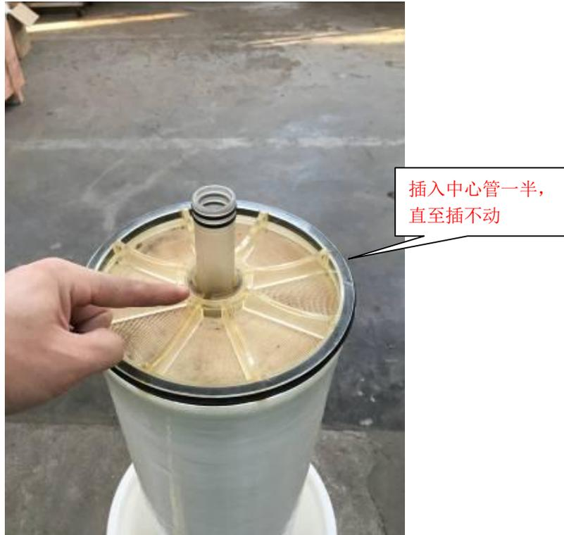
2、将膜芯从膜管的进料端装入，并且没有密封圈的一端先进，将膜芯插入三分之二处即可，不能全部插入；
