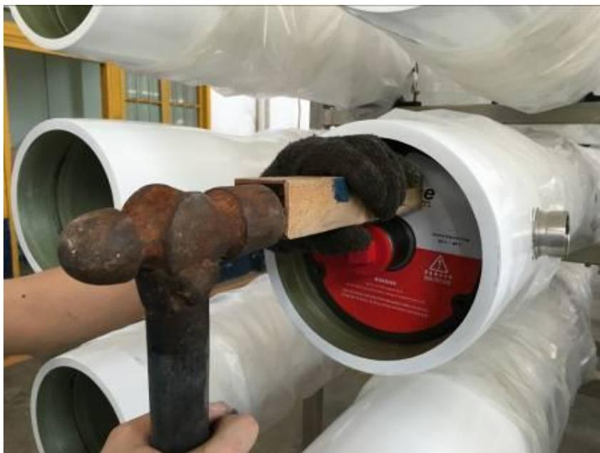
当端盖被敲入直到露出整个半月卡环的卡槽即可；
